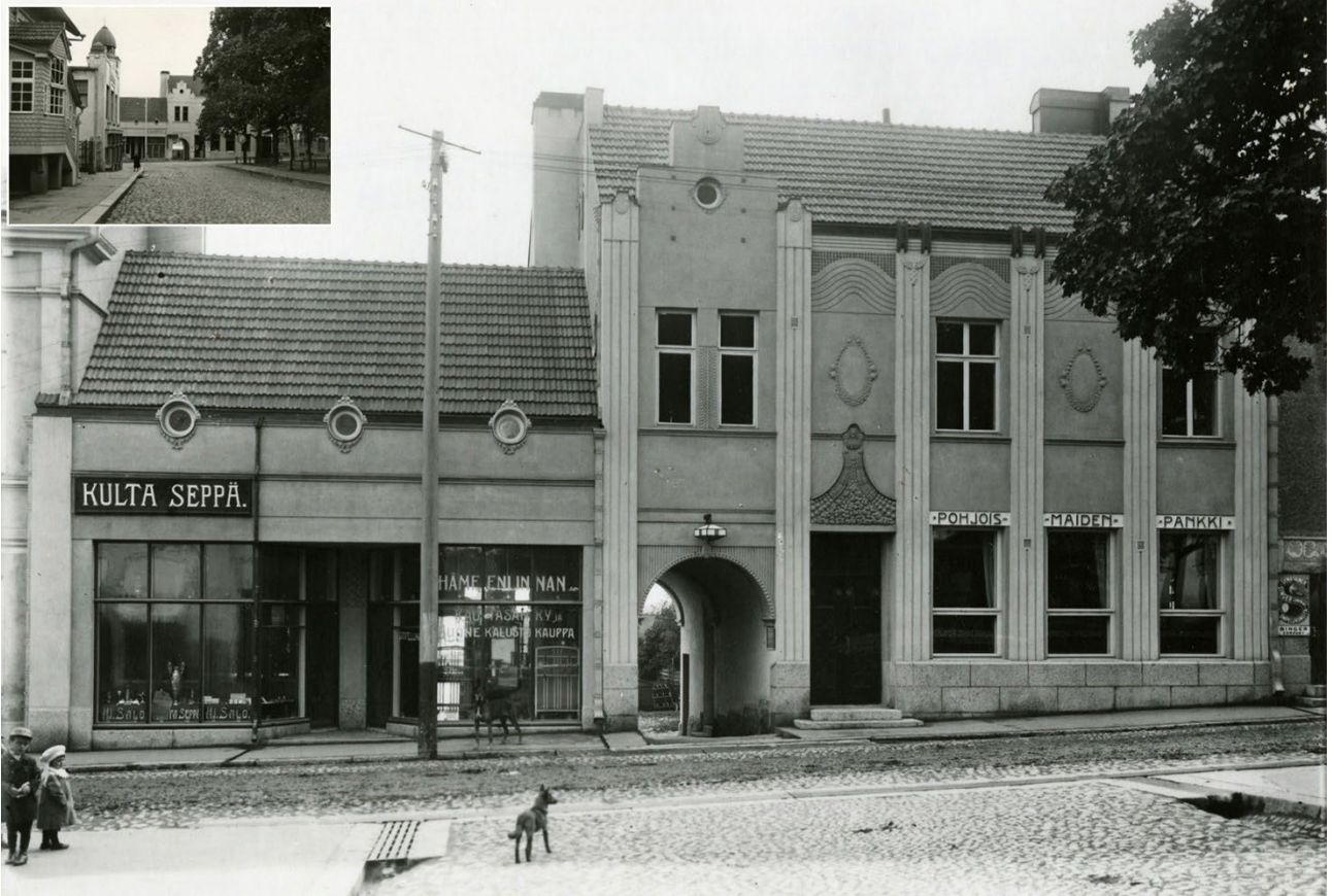
Kuva 3 Raatihuoneenkatu 9:n rakennuksia noin 1910 Kirkkorinteestä kuvattuna. Kuvaupotuksessa sama näkymä 30-50 vuotta myöhemmin. (kuvat: Hämeenlinnan Kaupunginmuseo)
