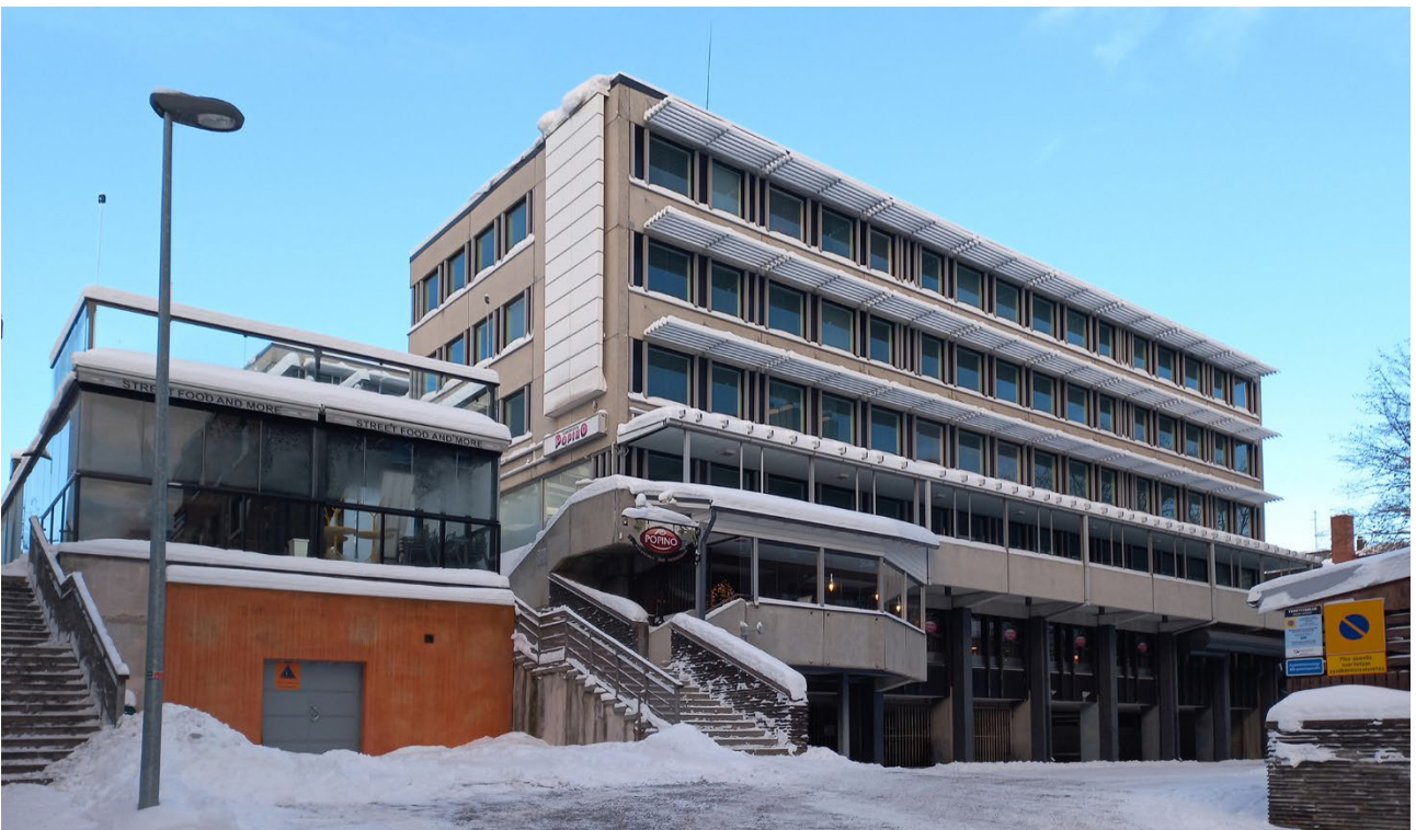
Kuva 16 Valokuva Raatihuoneenkatu 11 alapihalta.
