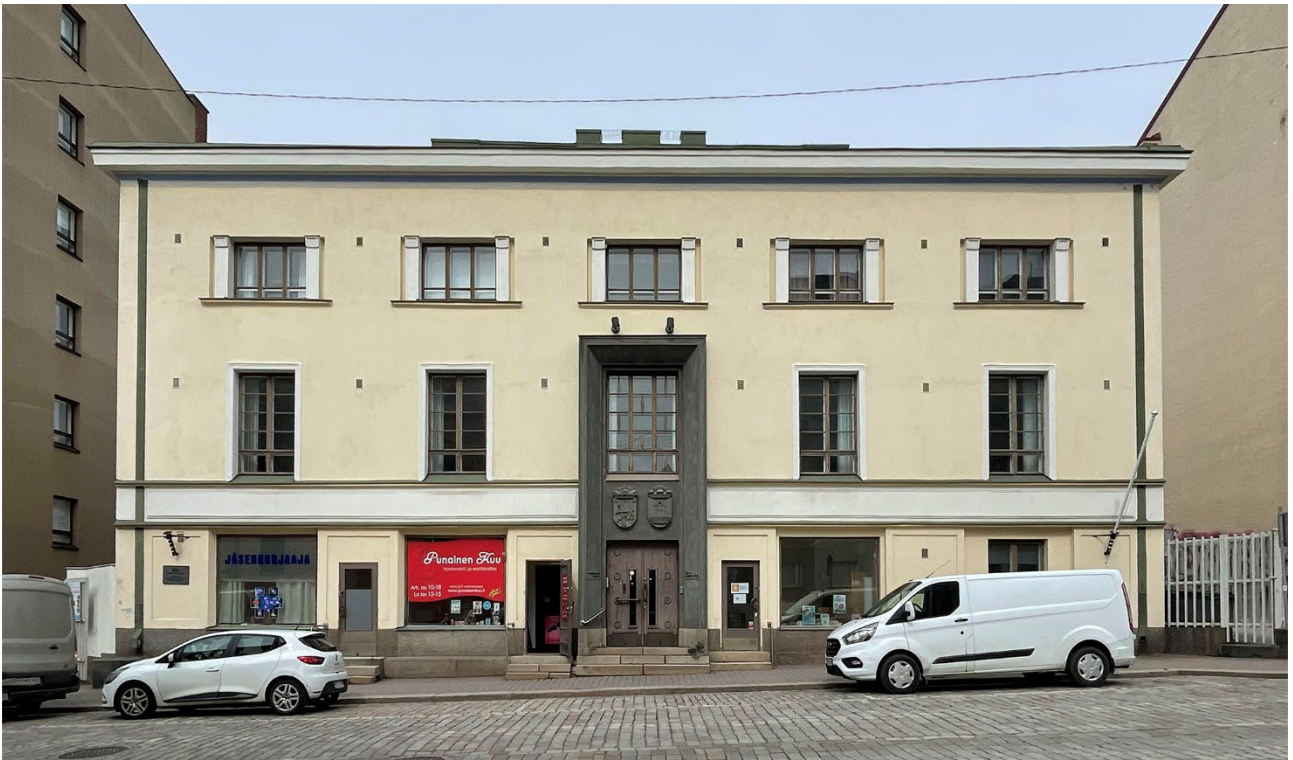
Kuva 17 Hämeen Suoja kuvattuna Palokunnankadun eteläpuolelta keväällä 2024.
