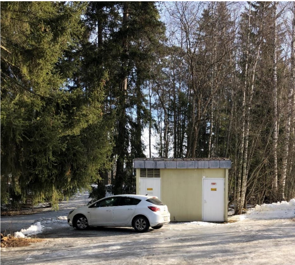
Kuva 8. Kuvassa näkyy tontin vieressä sijaitseva muuntamo.
