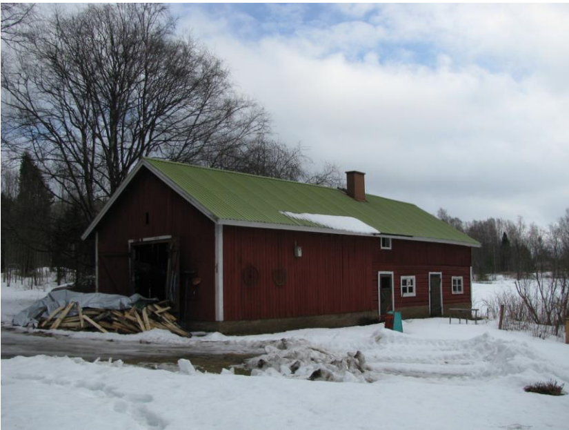
Kuva 9. Tilan Telkkä I navettarakennus.
