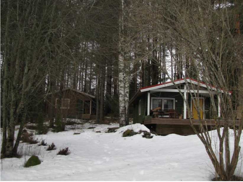
Kuva 10. Tilasta Telkkä I vuokratulla alueella sijaitsevat rakennukset.
