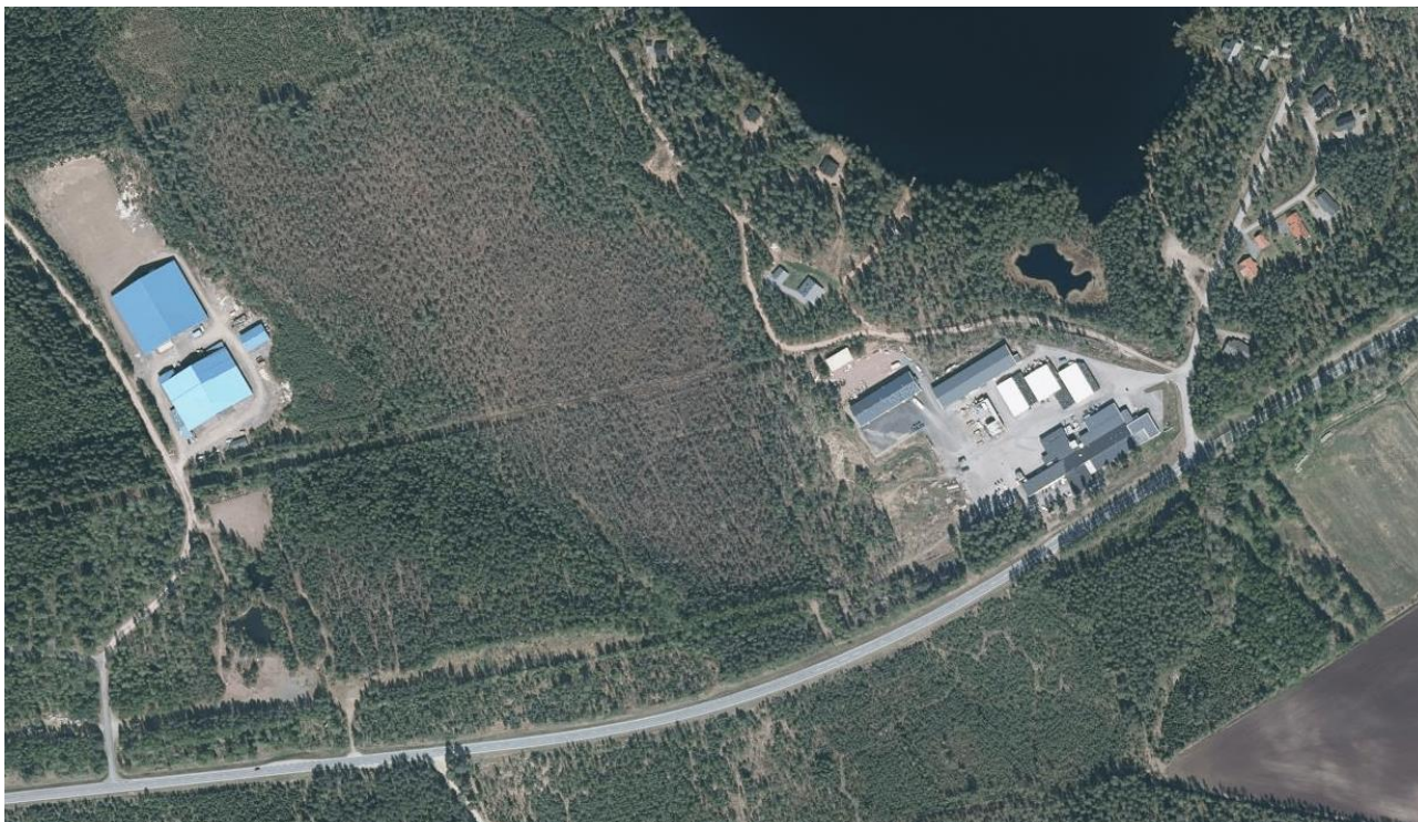
Kuva 8. Yleiskuva suunnittelualan rakennuskannasta vuonna 2022 otetussa ilmakuvassa.
