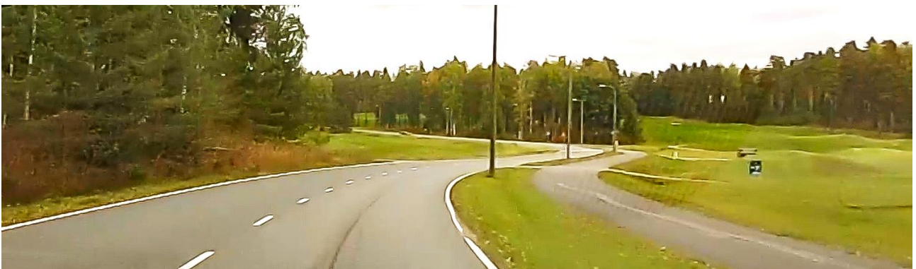
Kuva 29: Vanajanlinnantietä 2022, pohjoinen suunnittelualue oikealla.
