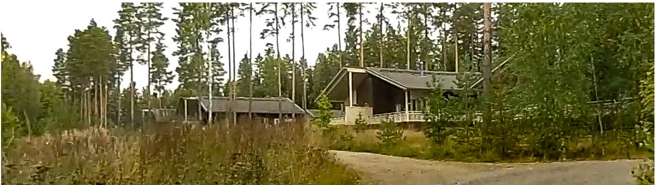
Kuva 24: Eteläisen alueen toteutuneita rakennuksia 2022
