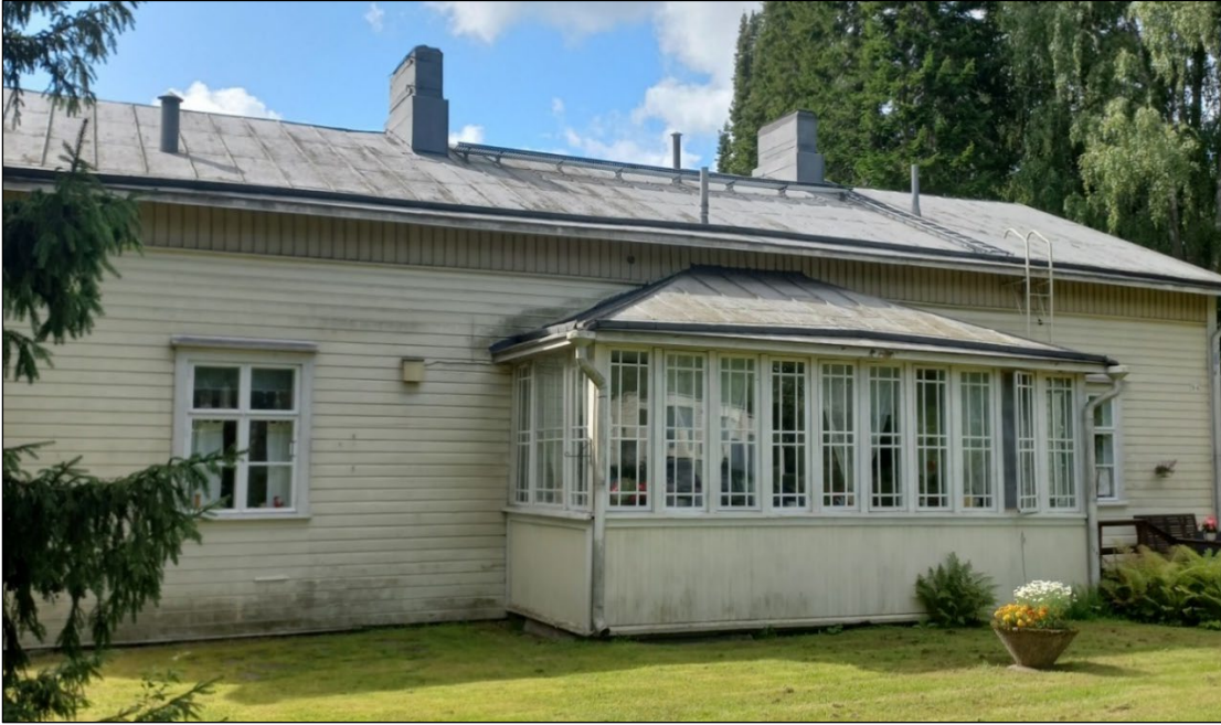
Kuva 5. Tontilla sijaitseva asuinrakennus. (Kuva: Aino Niiva, 2024)
