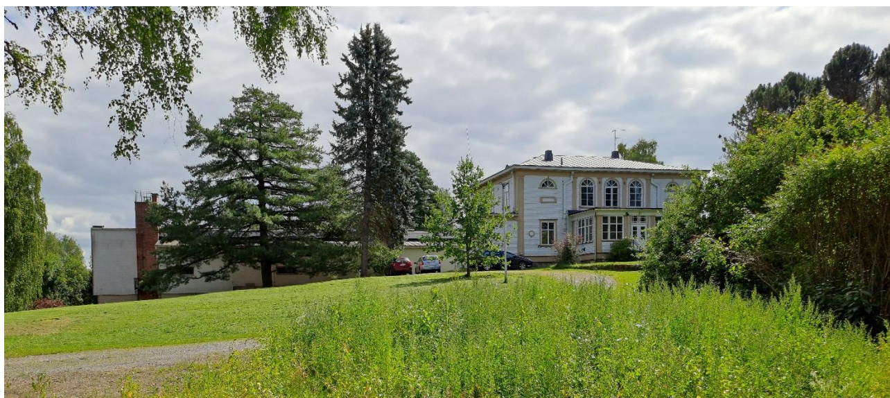
Kuva 7. Nuhalan koulu nähtynä pohjoisesta Koulutieltä elokuussa 2024. Vanhin osa koulurakennuksesta (oik.) sijoittuu suunnittelualueen korkeimmalle kohdalle, ja erottuu siten parhaiten maisemassa.
