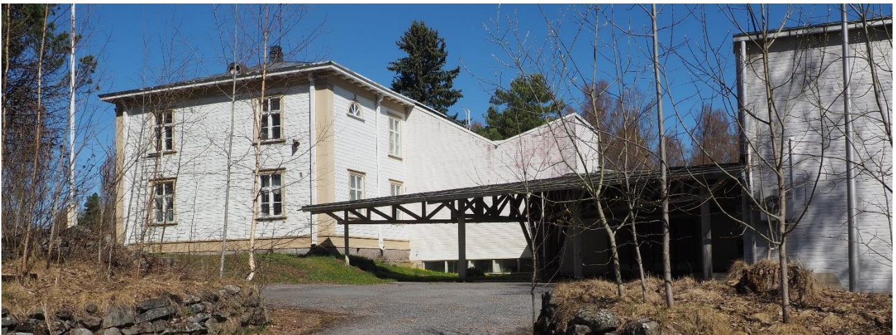
Kuva 12. Alkuperäisen rakennusosan ja lisäsiipien yhtymäkohta rakennuksen lounaispuolella.
