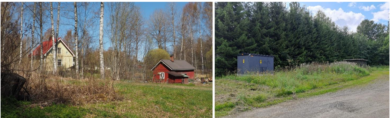
Kuva 13. Vasemmalla suunnittelualueella sijaitsevan pientalotontin rakennuksia. Oikealla toinen alueen puistomuuntamoista sekä pieni varistorakennus.
