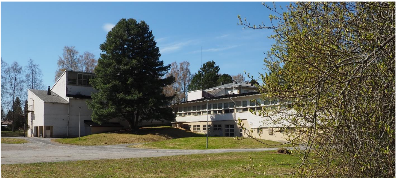
Kuva 9. Vasemmalla juhlasalisiipi ja oikealla luokkasiiven luokkahuoneiden ikkunarivistö.
