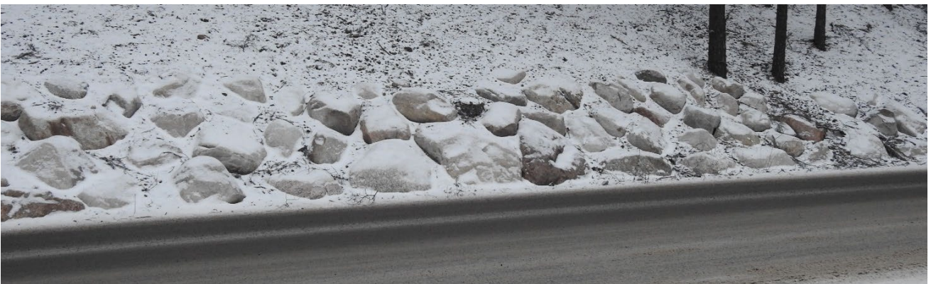
Kuva 2. Tontilta löytyviä luonnonkiviä hyödynnetään pengerryksissä.
