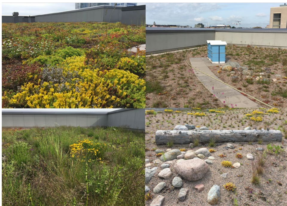
Kuva 4. Kasvikattotyyppejä on monenlaisia, kuten maksaruohokattoja, perennakattoja ja ketokattoja.
