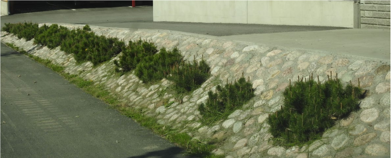
Kuva 1. Luiskat, jotka sijoittuvat pääsisäänkäynnin läheisyyteen, suositellaan niiden viimeistelyä seulanpääkiveyksin. Kiveyksen lomaan voi jättää istutusaukkoja paikkaan soveltuville kasveille.
