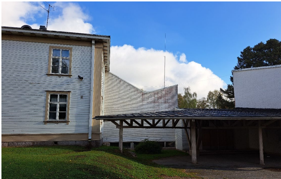
Kuva 5: Rakennuksen puu- ja kiviosien rajapinta, jossa kerroksisuus on erityisen näkyvissä
