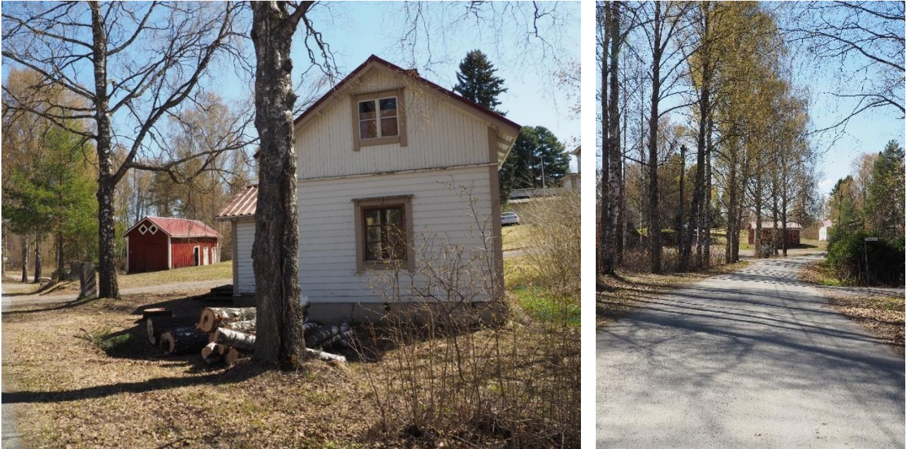
Kuva 19. Kylmä varastorakennus (vasemmalla takana) ja nk. terveydenhoitajan talo
