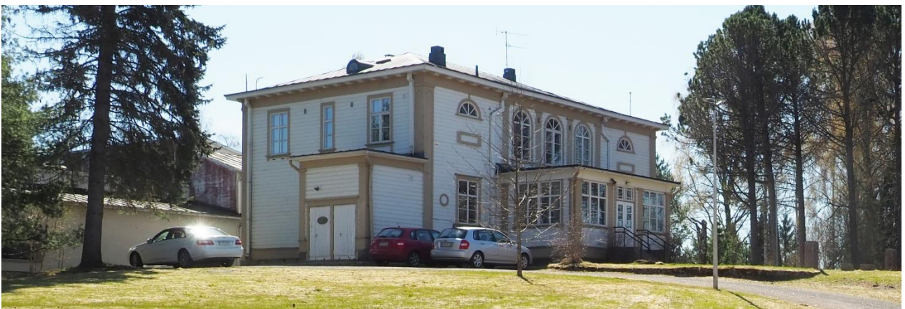
Kuva 14. Koulurakennuksen vanhin osa, joka alun perin rakennettiin huvilaksi.
