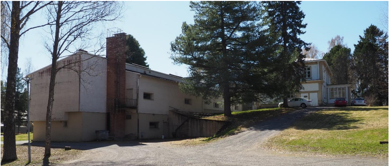
Kuva 18. Luokkasiipi ja puurakenteinen siipi.
